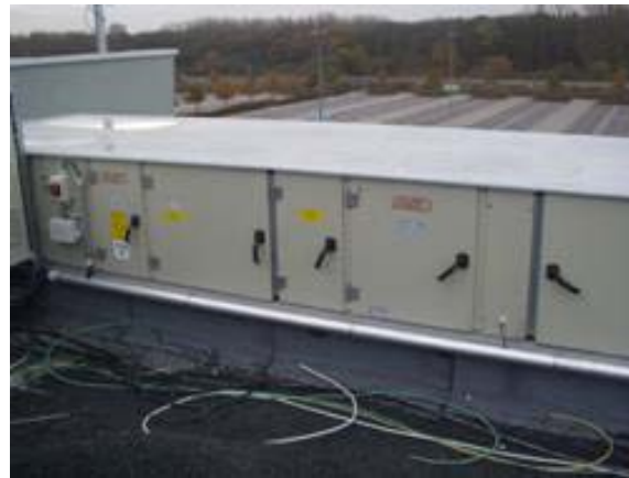
Пристрій централізованої вентиляції з рекуперацією тепла
